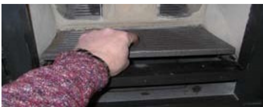
5. Gussrost entfernen
