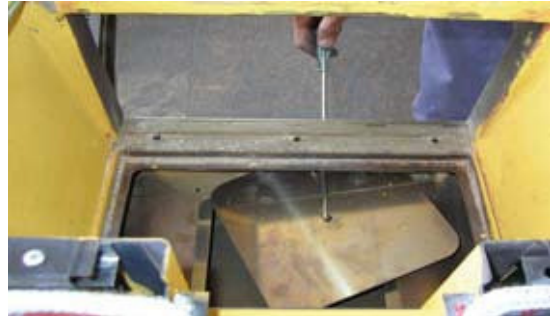
6. Die untere Abdeckplatte(n) der Rauchgaszüge entfernen; der K80 ist mit zwei Platten ausgestattet
